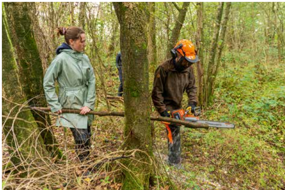
Mila Woudt (l) en Renske Jutten (r) maken van dunne boompjes palen voor het vissenbos. De palen worden in een driehoek in de beekbodem gedrukt en vervolgens opgevuld met takken.
